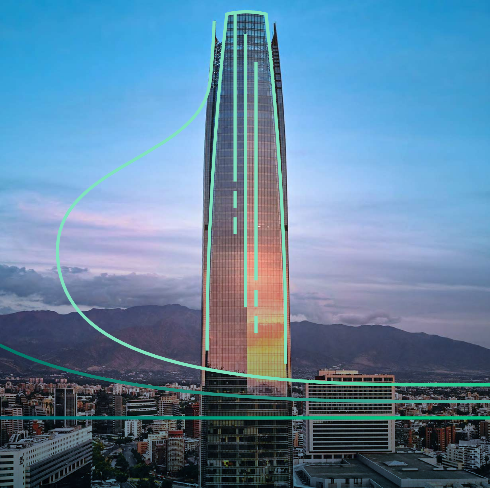
Costanera Center, Santiago. Obra Cbb Ready Mix.
