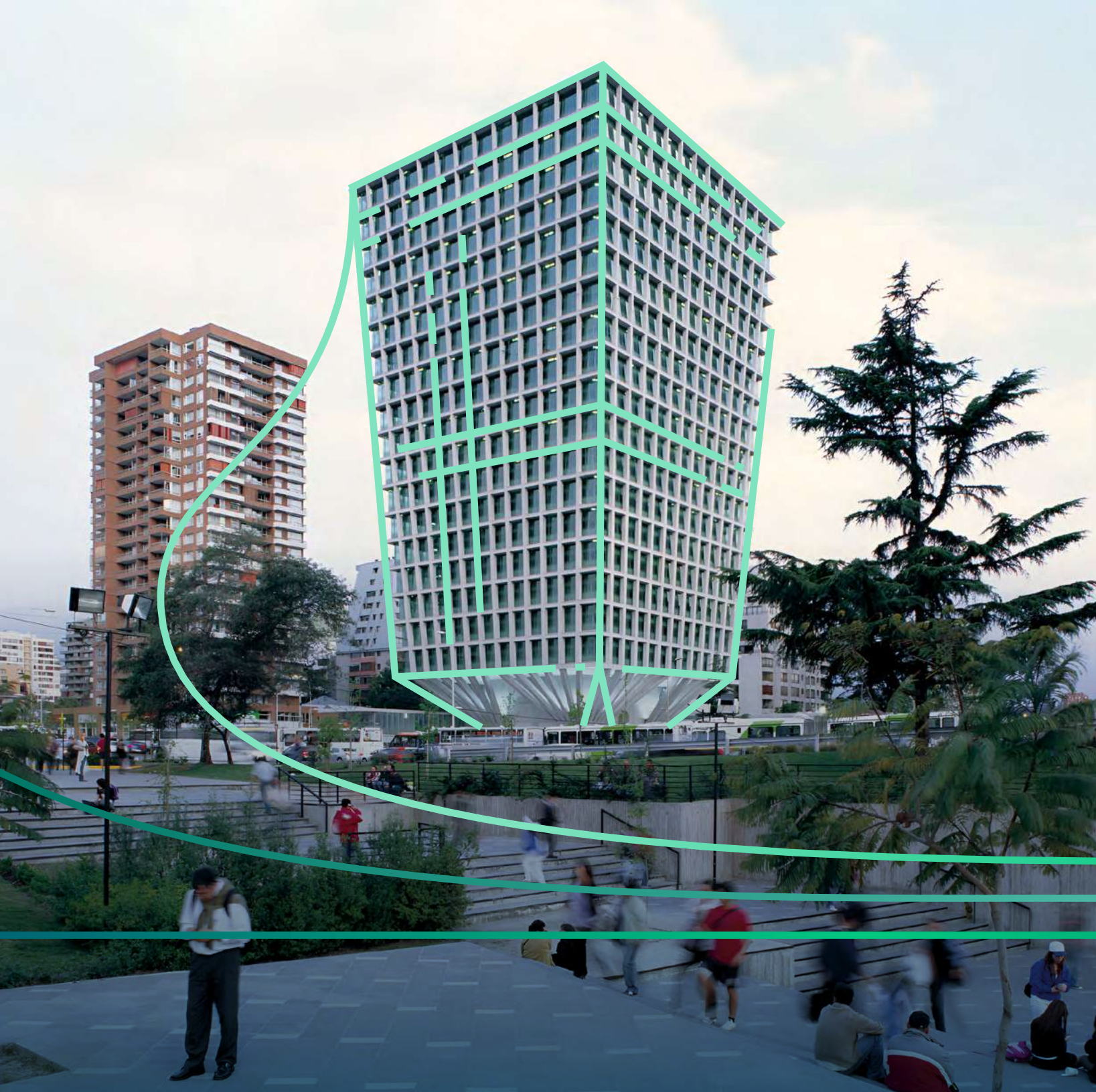
Edificio Cruz del Sur, Santiago. Obra Cbb Ready Mix.
